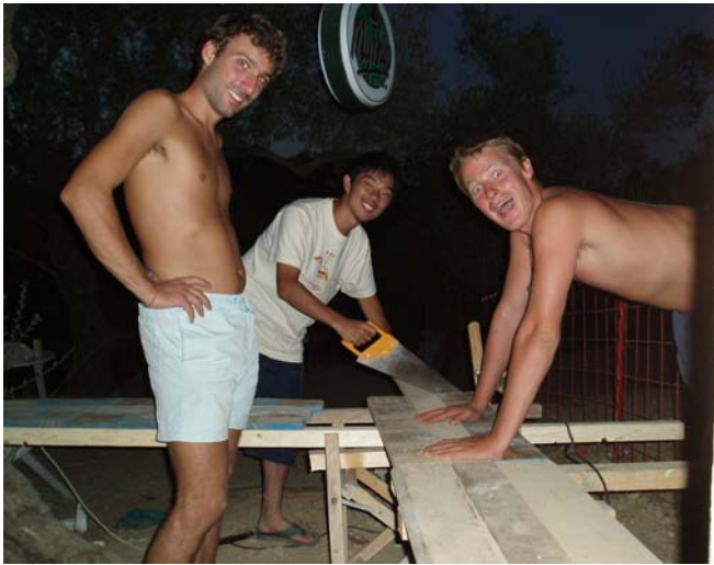
写真7 ベンチの工事中。全て自分達で賄います。
