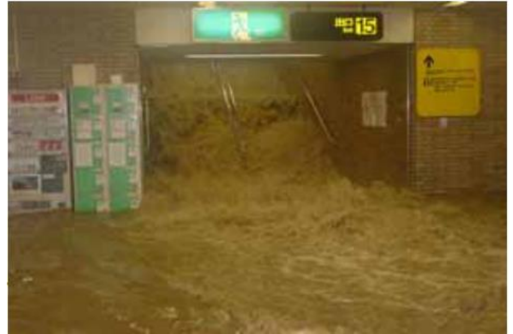
2003年7月 福岡市での地下浸水
