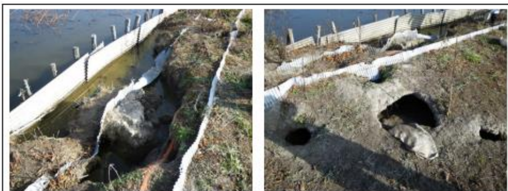
水田の畦の破壊状況
