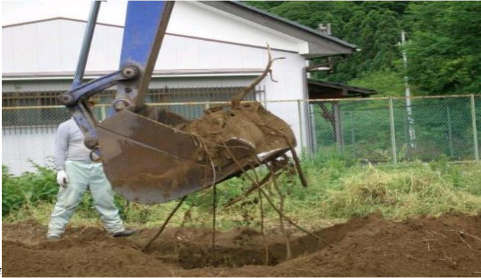
図 3-1. ニセアカシアの地下根除去作業
