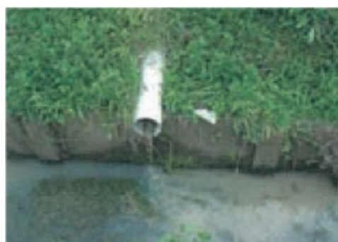
③ 尻水戸からの漏れ
