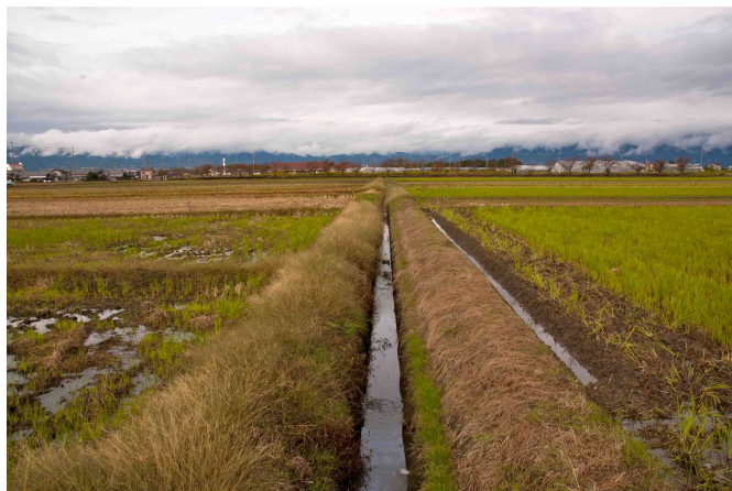
図 10 排水路の様子
