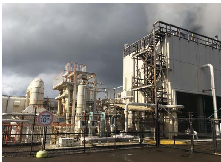
図3-6 八丈島発電所 東京電力運営 筆者撮影
