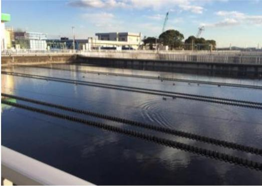
図 5-5 水処理 沈殿池
