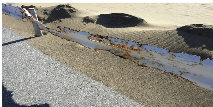
図 16:腐食の進んだガードレール 幕張海岸にて筆者撮影
