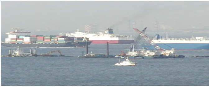
30 写真 7 第三海堡の撤去工事現場
