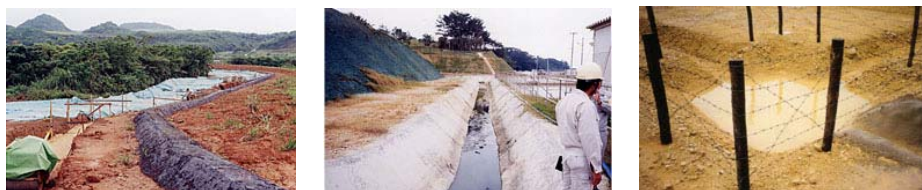
左から 小堤工(表面流出抑制工)、切り回し水路(水路・流出抑制工)、土砂溜舥(水路・流出抑制工)
