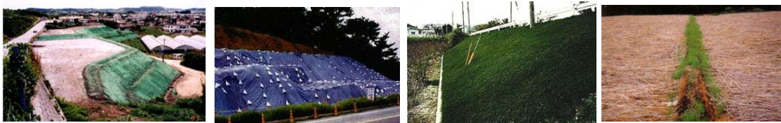
左から 土壌団粒化剤+種子吹付、シート被覆工、芝による法面緑化、マルチング(枯葉等による表面被覆) 出典：沖縄県 HP
