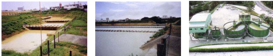
左から 自然沈澱池、ろ過・沈澱池方式、機械処理方式
